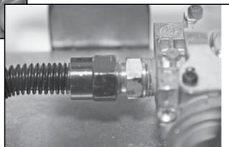
Fixez le connecteur de gaz à la conduite d'alimentation en gaz et connectez-le à la vanne de gaz de l'ensemble brûleur. Utilisez de l'eau savonneuse pour vérifier les connexions pour les fuites. "Un connecteur de gaz plus long peut être nécessaire pour des installations uniques" (non fourni). (Figures 3.1 et 3.2)
